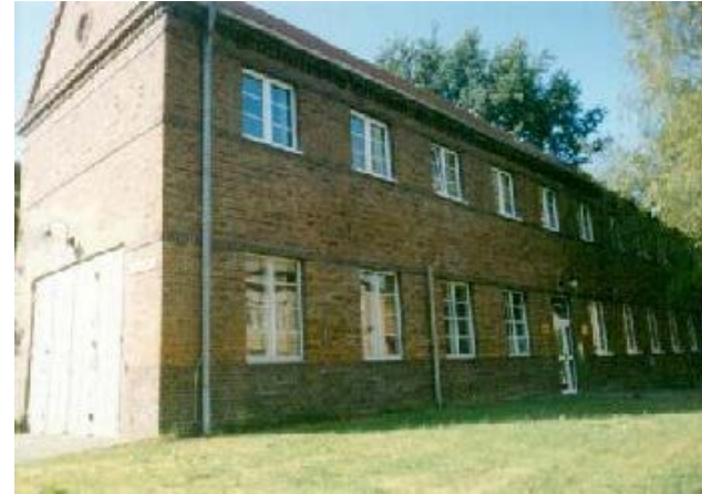
Technische Leitzentrale, Kastanienallee (gegenüber Heizkraftwerk)
